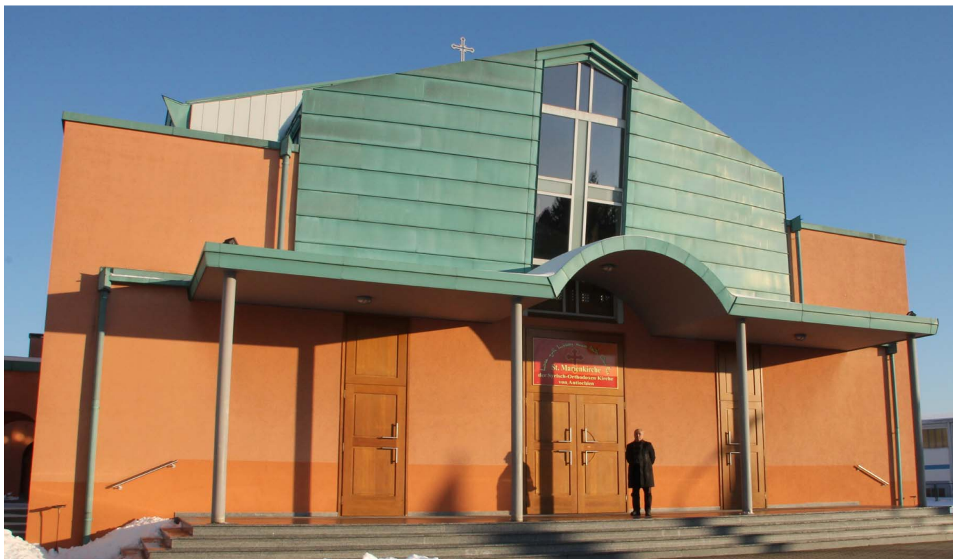
Die syrisch-orthodoxe Kirche von Antiochien ist seit 1998 in diesem Gebäude in Lechhausen untergebracht. Danyel Akgüc freut sich, den Gläubigen Hilfe und Unterstützung anbieten zu können. Fotos: Marta Antonova
